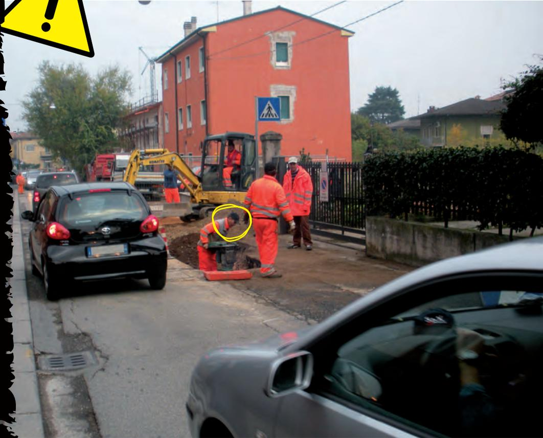
Esempio di lavorazione con presenza di rumore e vibrazioni, l'operaio non indossa le cuffie e il casco.
