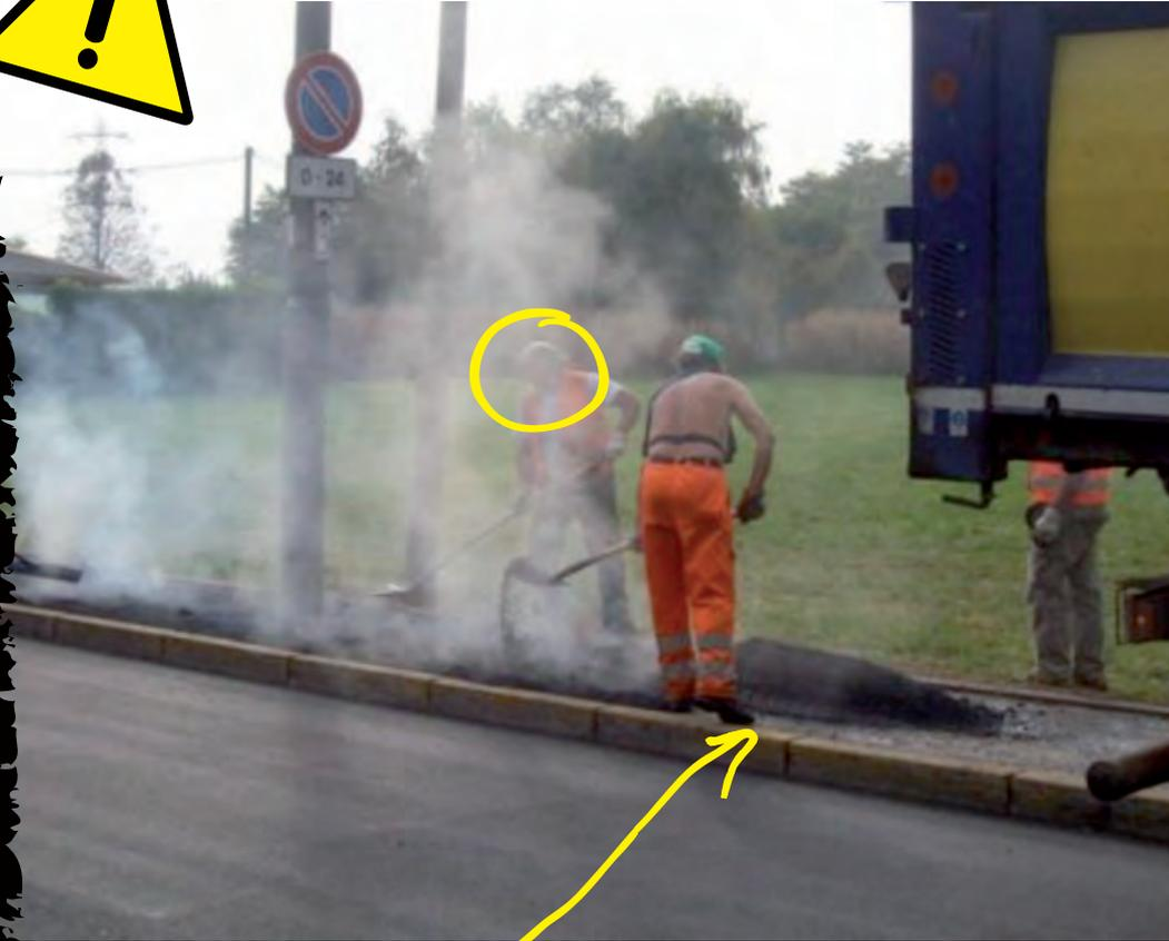
Esempio di stesura di catrame con necessità di lavori manuali. Situazione non regolare, i lavoratori non usano le protezioni delle vie respiratorie e non indossano il casco di protezione.
