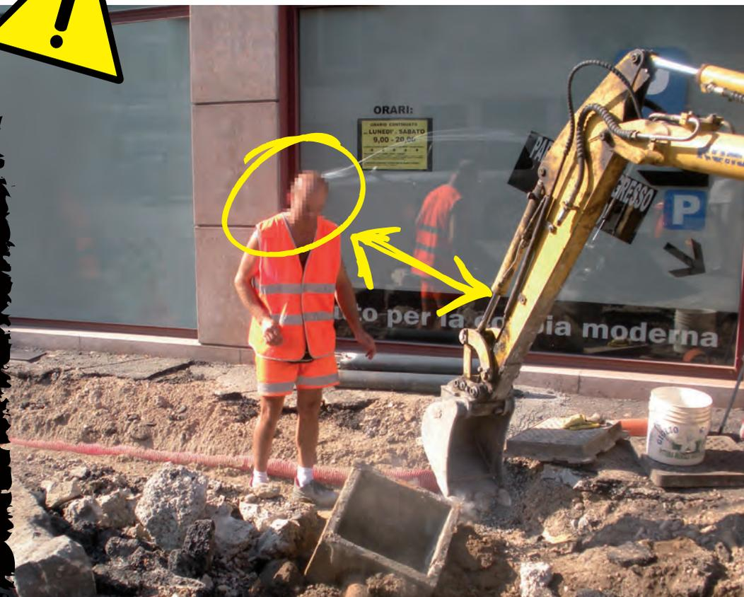
L'operaio si trova vicinissimo alla benna della pala meccanica in funzione durante uno scavo e non indossa il casco di protezione. Elevato è il rischio di urto e contatto con la benna.
