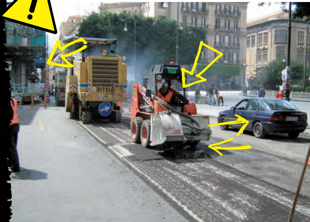
Il cantiere stradale per lavori di raschiatura e di asfaltatura è **privo di qualsiasi delimitazione dal lato del traffico.**
