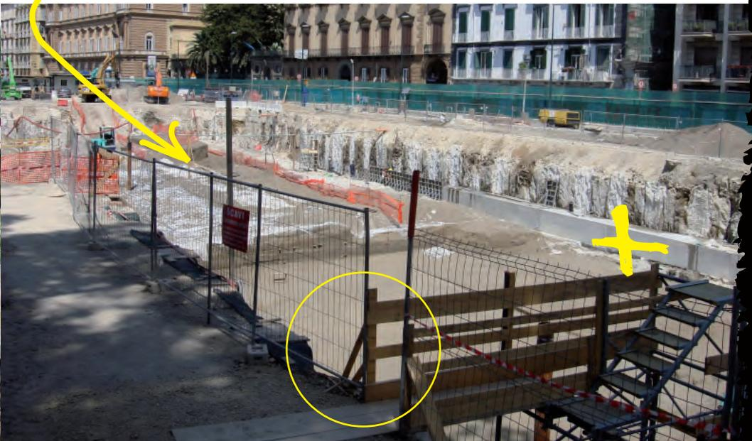
Situazione regolare perchè sono state predisposte **le delimitazioni** che impediscono la caduta nello scavo e **le armature** che evitano il franamento o il cedimento delle pareti dello scavo.
