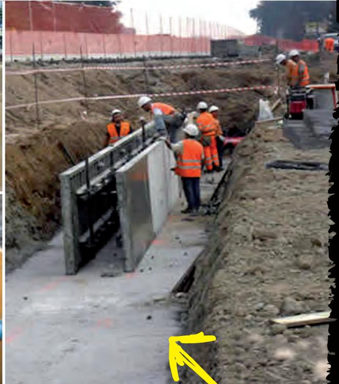
Per lavorare all'interno dello scavo è necessario mettere in sicurezza le pareti per evitare il cedimento delle stesse usando **apposite protezioni in base all'esigenza** (nelle foto sono riportati tre esempi di **blindaggi**).
