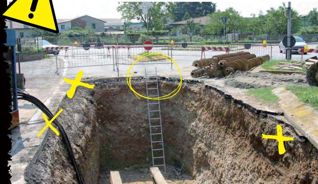
**Situazione gravemente irregolare:** il fronte scavo è verticale, profondo più di 1,5 metri, senza protezioni contro la frana e contro la caduta di lavoratori dentro lo scavo, la scala è troppo corta e non sporge in maniera sufficiente dallo scavo ed inoltre non è fissata.
